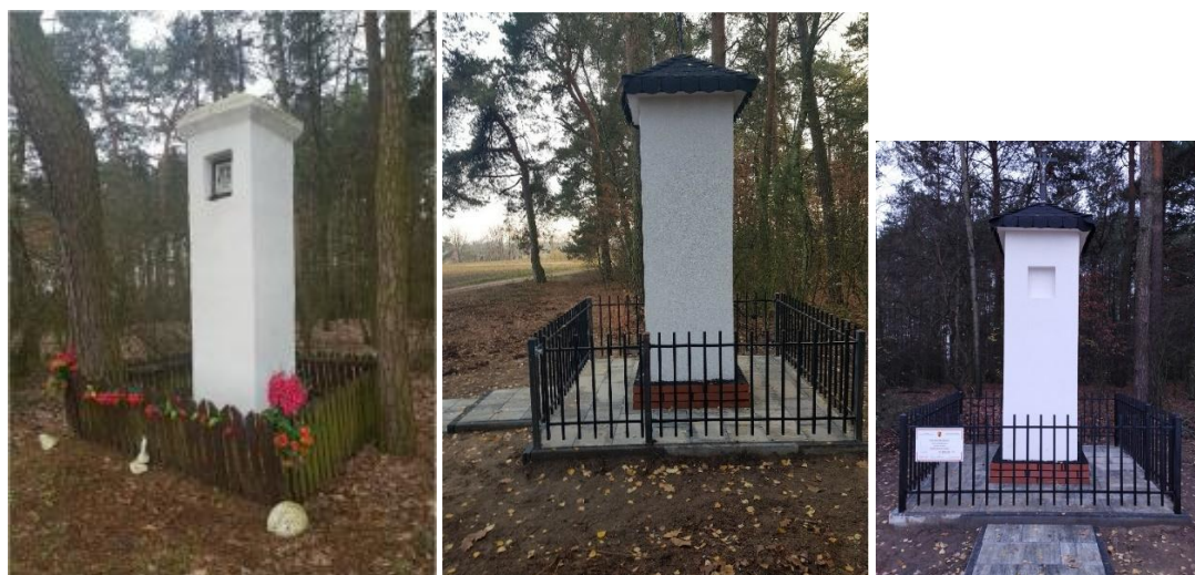
Fot. Renowacja kapliczki w miejscowości Studzianki
