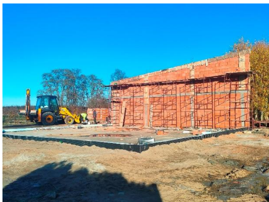
Fot. Powstający budynek garażu OSP Sadkowice
