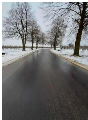
Droga po remoncie w miejscowości Zaborze
