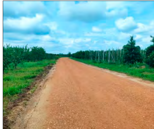
▪ Droga w miejscowości Gogolin
